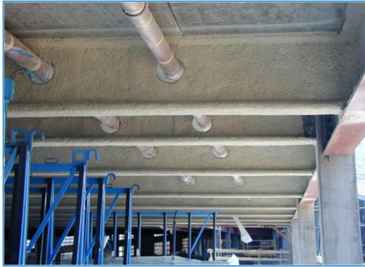
رش المواد الأسمنتية على الجسور الحديدية
